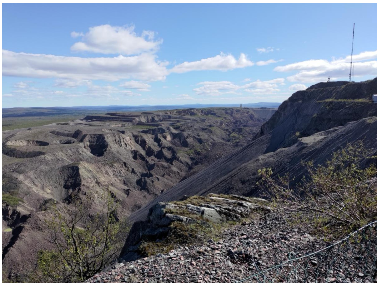
Figure 1. Vue sur la partie aérienne du site de Kiruna. Aujourd'hui, la totalité de l'exploitation est souterraine.
