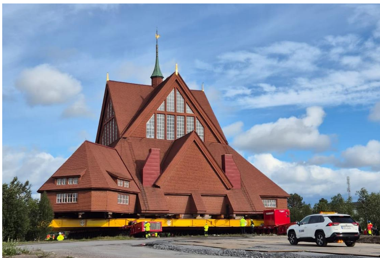
Figure 5. Le déplacement de l'église de Kiruna sur une distance de 5 kilomètres en 2 jours.
