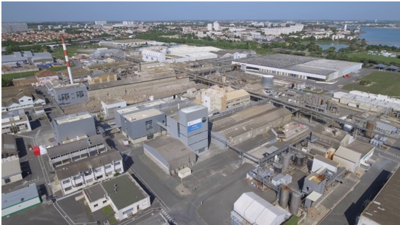
Usine de La Rochelle (Solvay)
